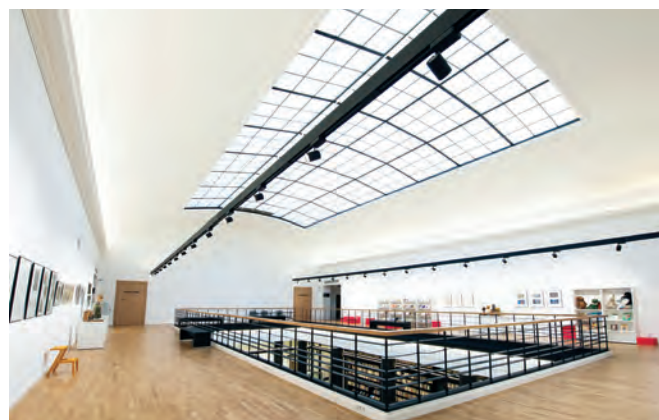
Atrium-ul de la etajul V, un loc pentru expoziții comerciale, evenimente, întâlniri. Foto de Vygailė Šukurytė.
