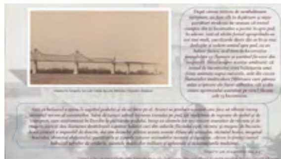
Momentul încercării podului cu un tren de 15 locomotive.
