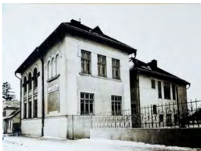
Școala primară de fete Suceava. Se observă în partea stângă vechiul imobil care a adăpostit grădinița și apoi locuința directorilor, în locul căruia se va construi viitorul hotel, azi Corpul B al Bibliotecii. Sursa: SJSAN, Fond Camera Agricolă a județului Suceava
