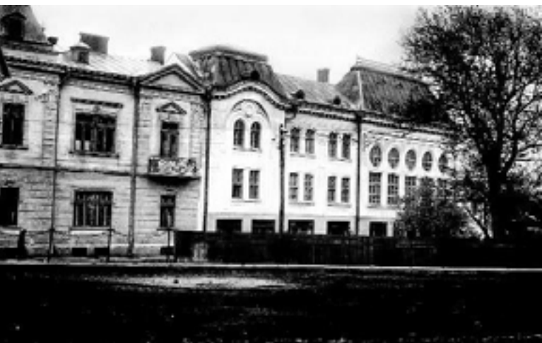
Casa Națională (din arhiva personală Dumitru Balint). Se observă în partea stângă imobilul vechi (casa Halpern) construit la începutul sec. XX, în prelungirea căruia s-a construit aripa nouă a Casei Naționale Sursa: https://www.facebook.com/legacy/notes/1793131024317401
