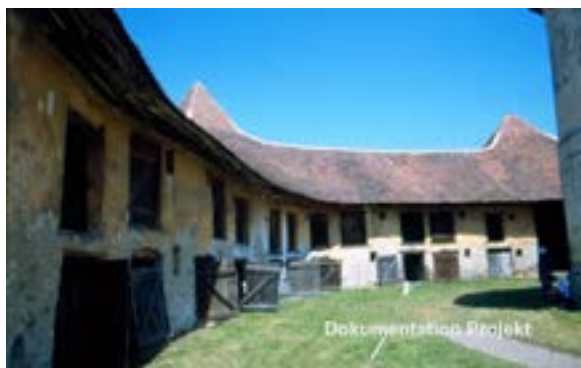
Fig. 50. Sânpetru/ Petersberg. Încăperi folosite ca locuințe în timpul asediilor, iar în timp de pace, ca magazine de provizii, pe vestul și nord-vestul fortificației bisericii evanghelice, 12 iulie 1995. Diapozitiv. Foto: Aurelian Stroe (imagine din Dokumentation Projekt).
