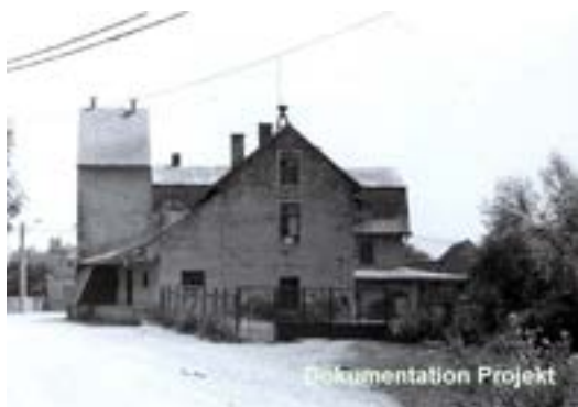
Fig. 44. Prejmer/ Tartlau. Uzina electrică („de apă”) și moara 852, 15 iulie 1995. Foto: Aurelian Stroe (imagine din Dokumentation Projekt).
