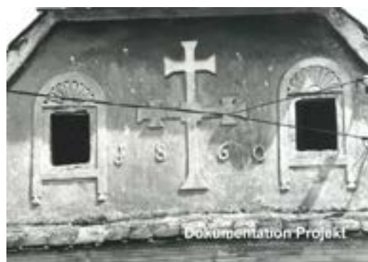
Fig. 47. Șaroș pe Târnave/ Scharosch an der Kokel. Datăre (1860) pe pinionul casei 315, 7 iulie 1994. Foto: Aurelian Stroe (imagine din Dokumentation Projekt).
