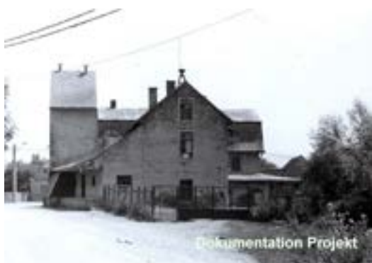
Fig. 44. Prejmer/ Tartlau. Uzina electrică („de apă”) și moara 852, 15 iulie 1995. Foto: Aurelian Stroe (imagine din Dokumentation Projekt).
