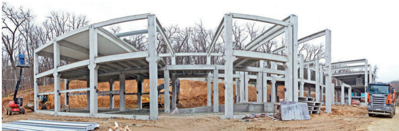
Foto 1. Fotografie realizată la începutul lucrărilor de construcție a Centrului ASTRA pentru Patrimoniu.
