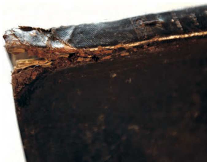
Foto 1. Deteriorări fizice ale copertei.
